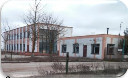
2 Комплекс (17 объектов - административное здание, склады для техники и транспорта, диспетчерская, сети). Собщ = 3987м 2 . дер.Плиса, ул.Заречная,62
