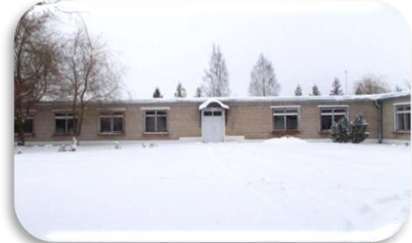
5 Комплекс (3 здания школы). Собщ = 1046м 2 аг. Голубичи, ул. Лесная, 17
